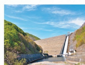
奈良俣発電所
